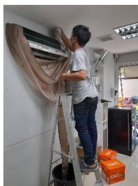
รูปที่ 23 ช่างประจำอาคารทำความสะอาดเครื่องปรับอากาศ
