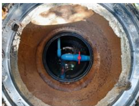
รูปที่ 41 เกทวาล์ว เพื่อป้องกันน้ำไหลย้อน
